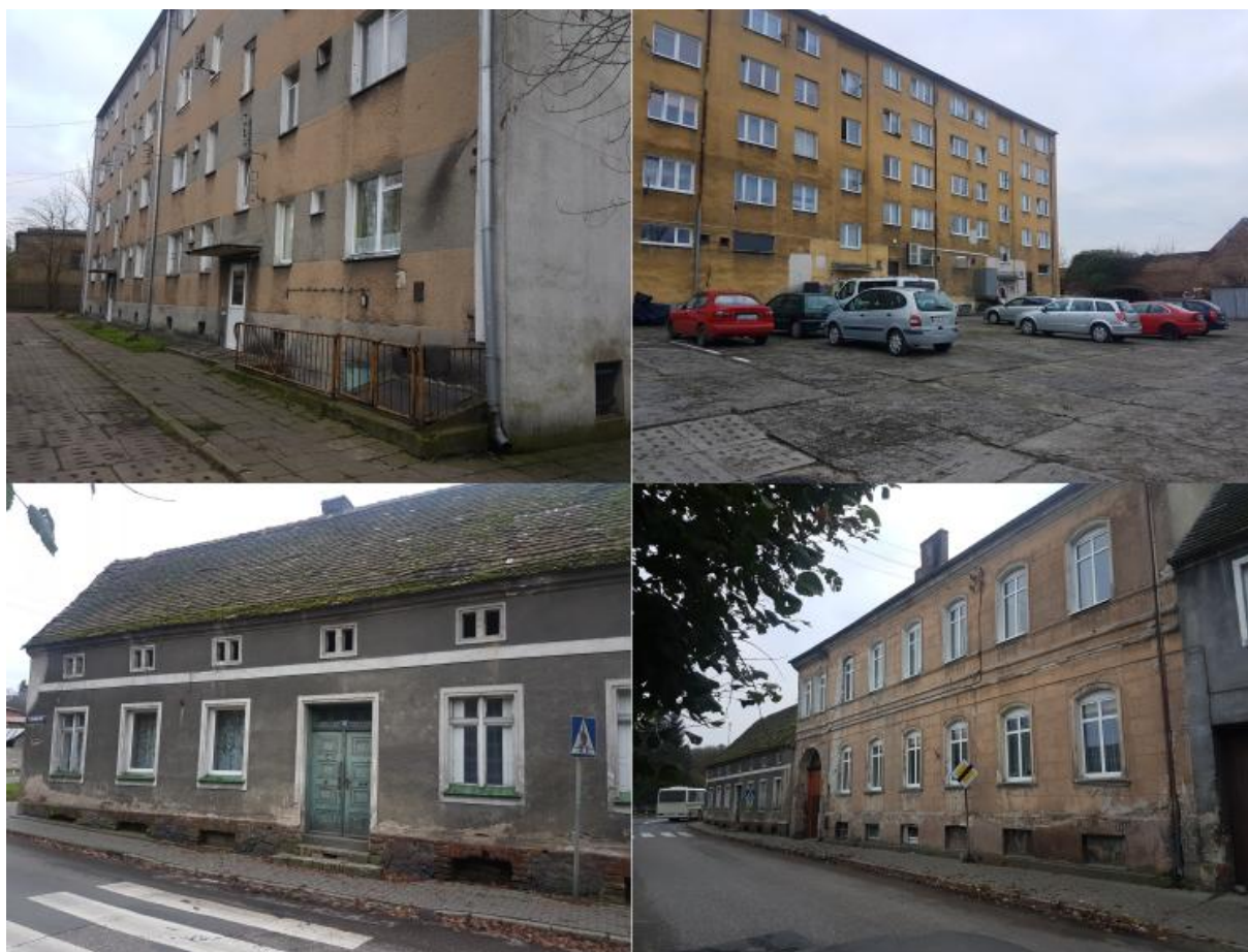
RYSUNEK 49. DOKUMENTACJA FOTOGRAFICZNA - PRZYKŁADY BUDYNKÓW MIESZKALNYCH W ZŁYM STANIE TECHNICZNYM
