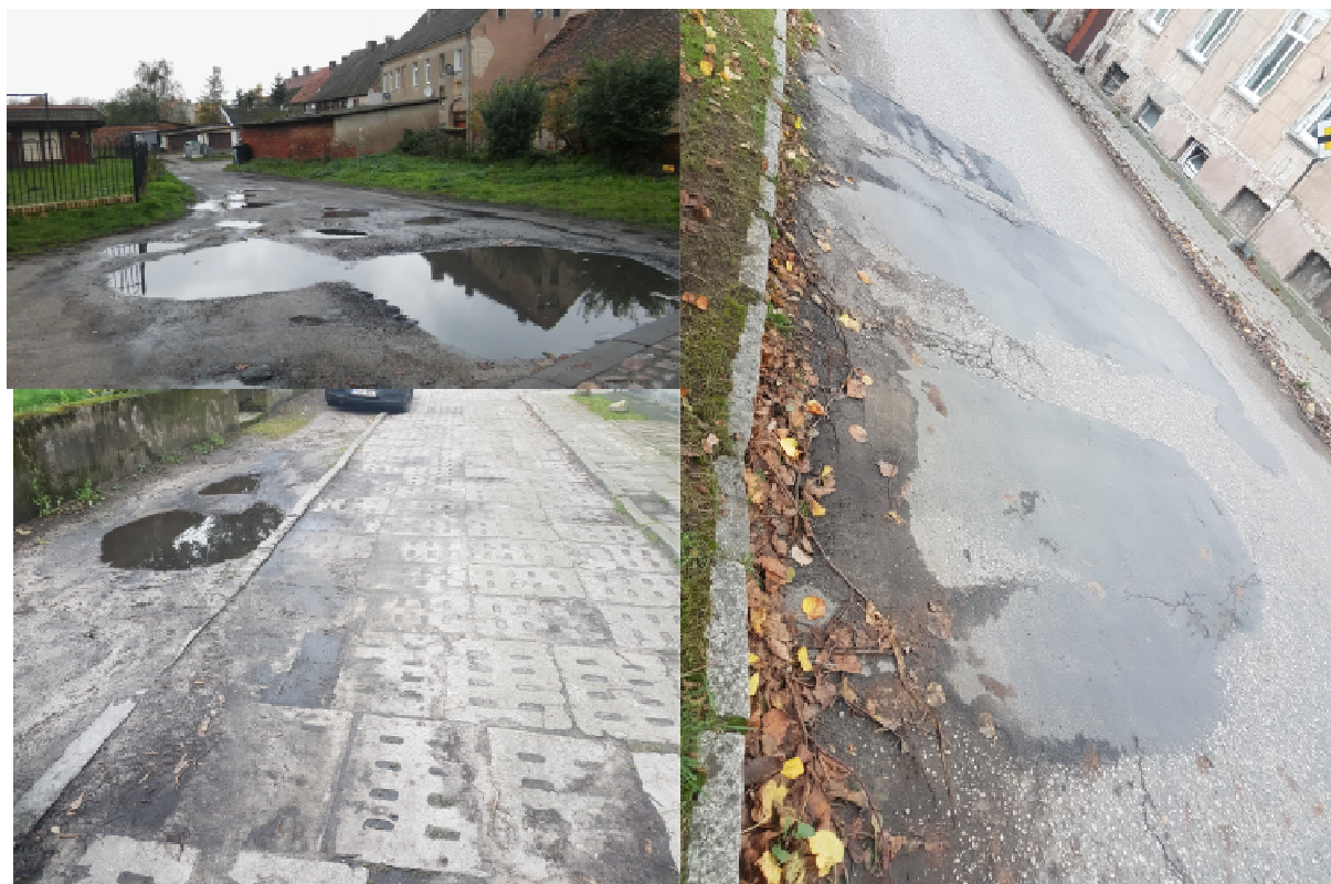
RYSUNEK 51. DOKUMENTACJA FOTOGRAFICZNA - STAN INFRASTRUKTURY DROGOWEJ
