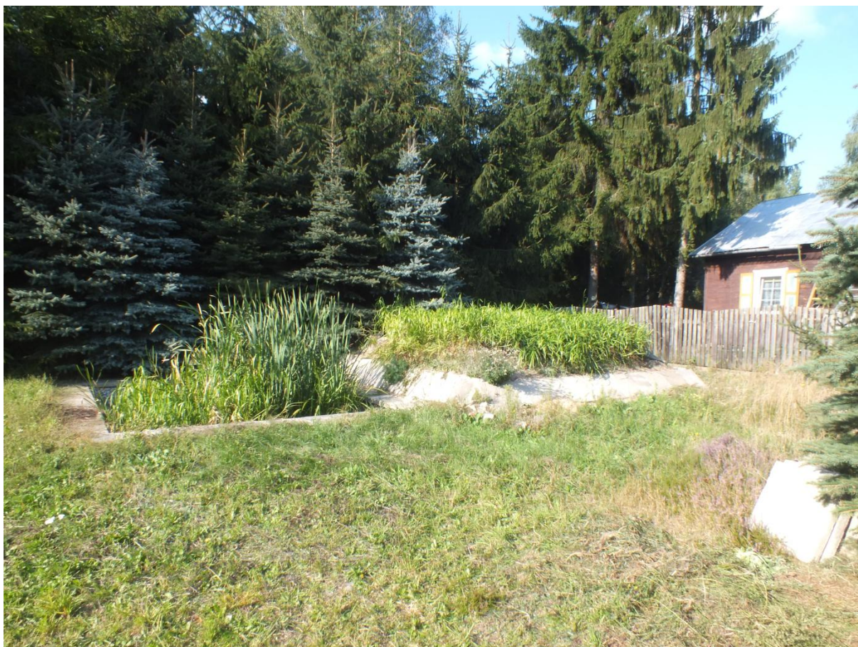
Rysunek 26. Oczyszczalnia hydrofitowa porośnięta roślinnością bagienną (źródło: zdjęcie własne, 2014r.)
