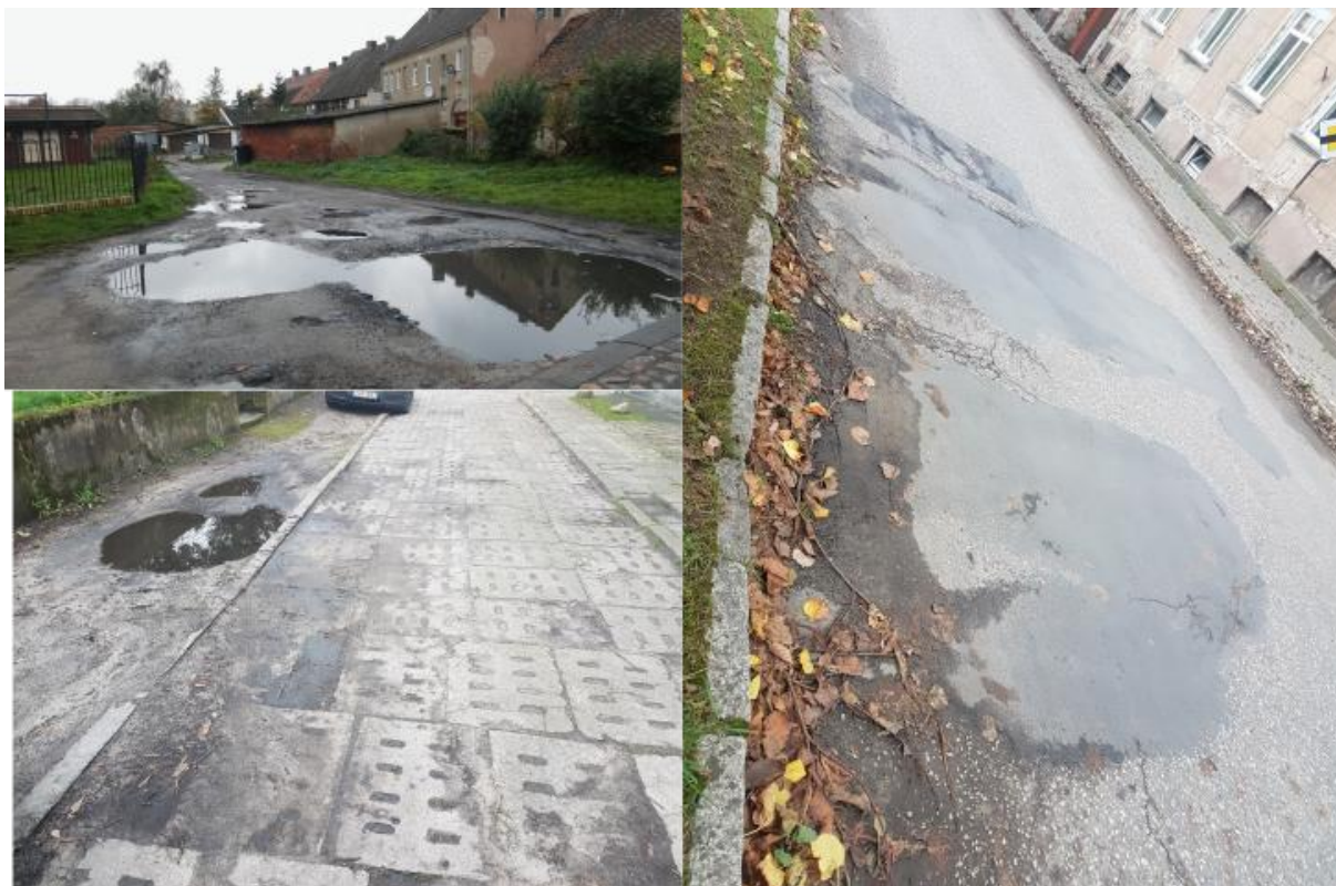
RYSUNEK 51. DOKUMENTACJA FOTOGRAFICZNA - STAN INFRASTRUKTURY DROGOWEJ
