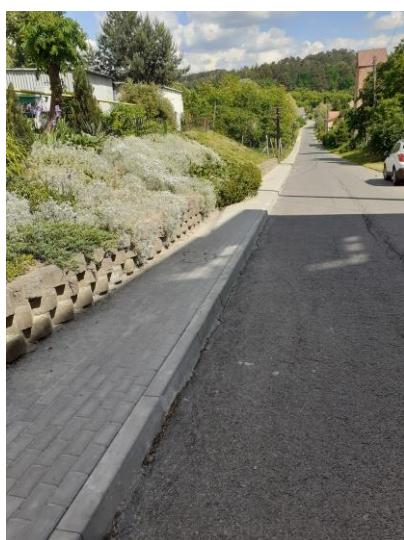
Remont chodnika w Widuchowej
