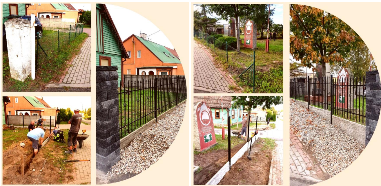
Wykonanie ogrodzenia terenu remizy OSP Krzywin
