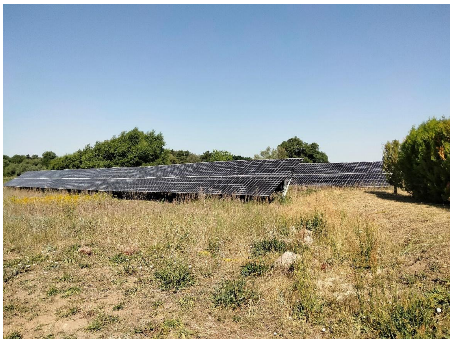
Fot. 1. Panele fotowoltaiczne na terenie kopalni.
