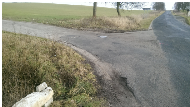
nawierzchnia w obrębie skrzyżowania z drogą powiatową km 0+000
