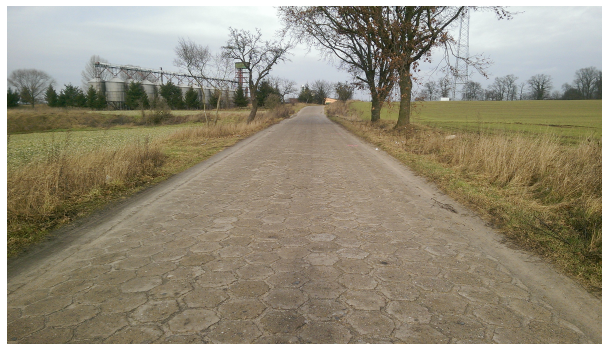
nawierzchnia z trylinki w km 0+300
