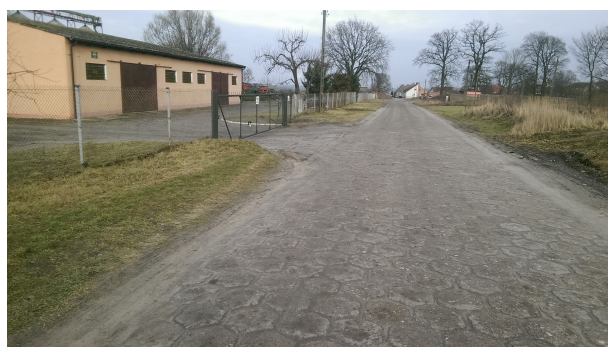
nawierzchnia z trylinki za istniejącym łukiem poziomym km 0+500
