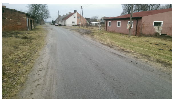
nawierzchnia bitumiczna w obrębie km 0+700
